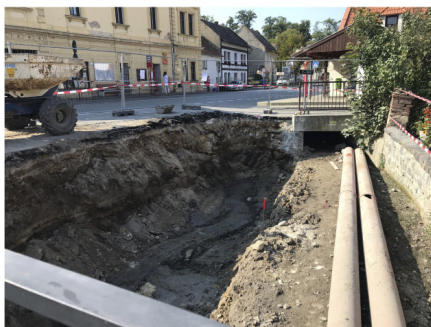
Výkopové práce u budovy městského úřadu
